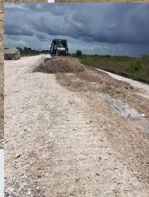
Cap backfill
